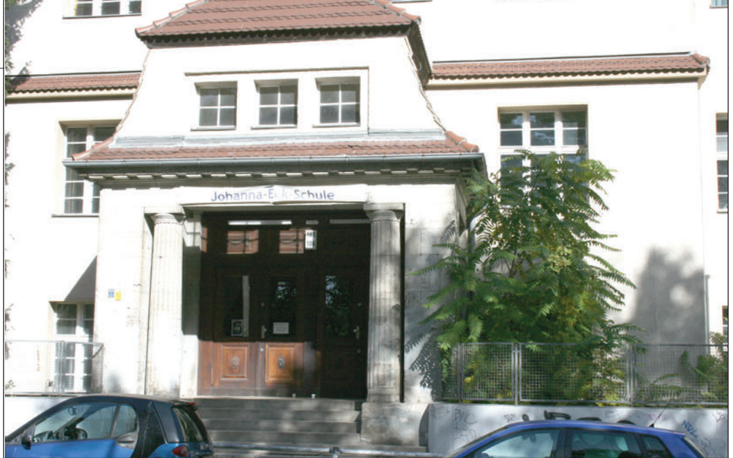
Das Hauptgebäude der Johanna-Eck-Schule in der Mariendorfer Ringstraße wurde bereits 1913 eröffnet und ist heute extrem sanierungsbedürftig. Fotos (2): Bothe
