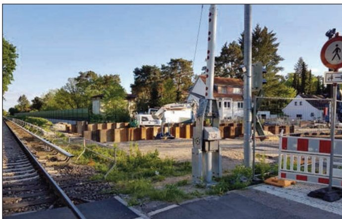
Bau der Unterführung am Übergang Wolziger Zeile.
