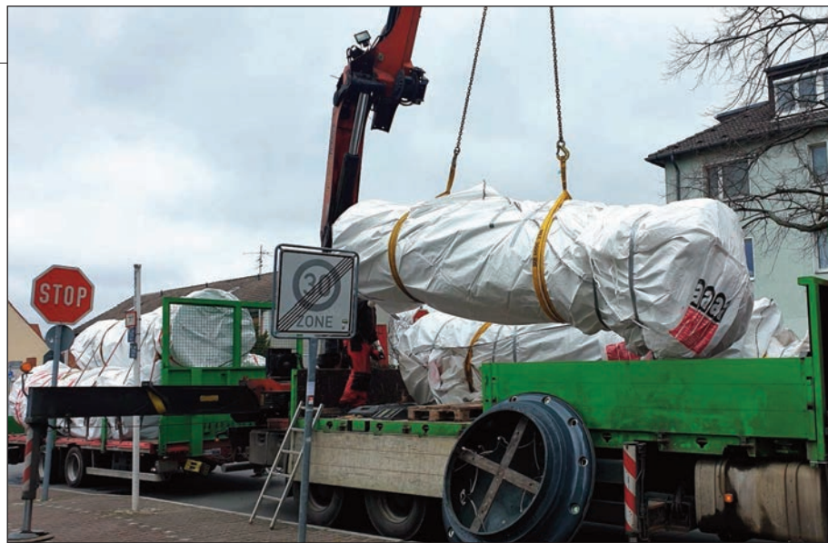
Alte Litfaßsäule in der Potsdamer Straße beim Ab- und Abtransport.
